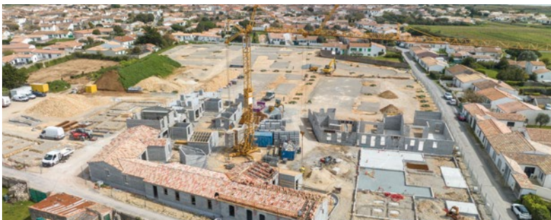
Construction de 48 maisons en accession sociale sur l'île de Ré par Maisons Prim'Access
