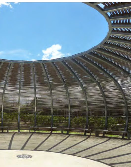
Structure d'ombrage Centre oenotouristique de Saint-Christol (84) Atelier Philippe Madec
