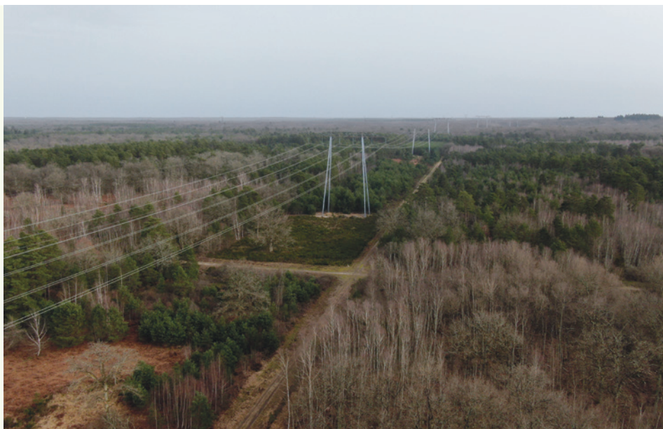
Chantier d'entretien de ligne électrique réalisé en 2021 dans le Loiret
